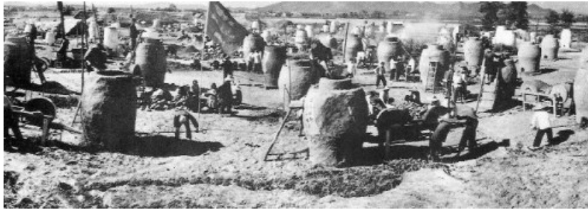
Hauts-fourneaux de village pendant le Grand Bond
